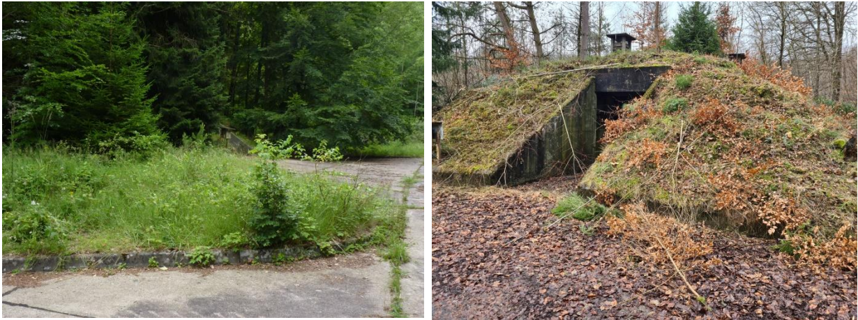
Abb. 16 : Maßnahme B2: Entbuschung und Mähen des Bunkerumfeldes. Foto | Philipp Schiefenhövel
