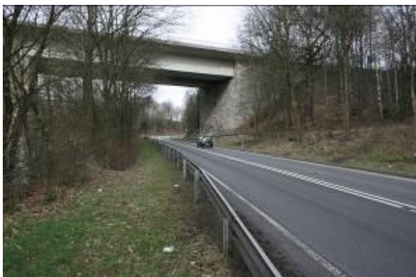
Abb. 3: Unterquerende Landesstraße L307 der Brexbachtalbrücke
