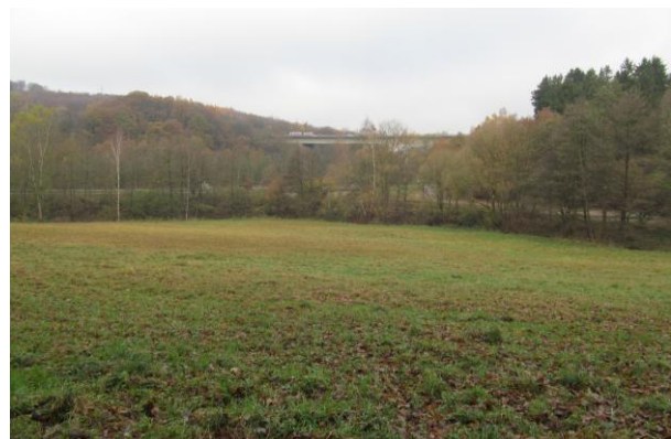
Abb. 4: Brexbachtalbrücke mit Blick von der Montabaurer Höhe
